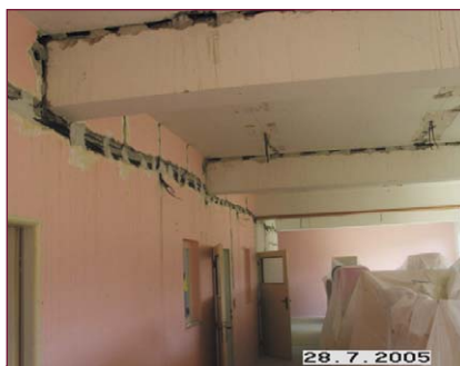
V pavilonu mateřské školky proběhla rekonstrukce elektroinstalace a nového osvětlení....
