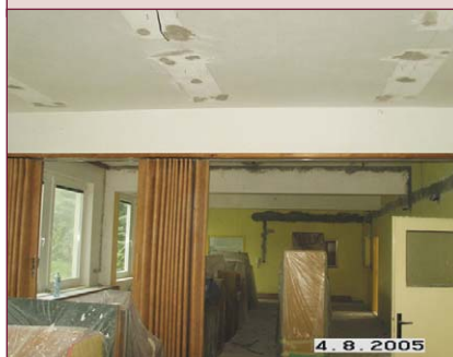
V pavilonu mateřské školky proběhla rekonstrukce elektroinstalace a nového osvětlení....
