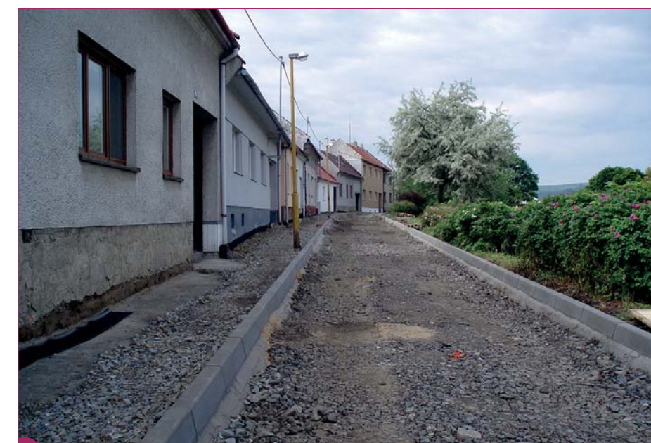
Celková rekonstrukce ulice Zábrani.
