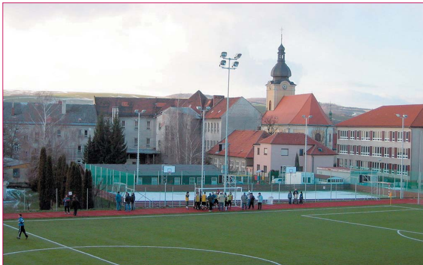
Rekonstrukce sportovního areálu u škol byla realizována také za pomoci státních dotací.
